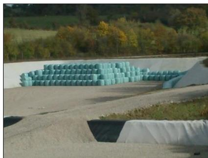
Les OMR sont conditionnés en balles, ce qui permet de diviser de moitié leur volume. Ces balles sont ensuite stockées dans une cellule de l'installation.
